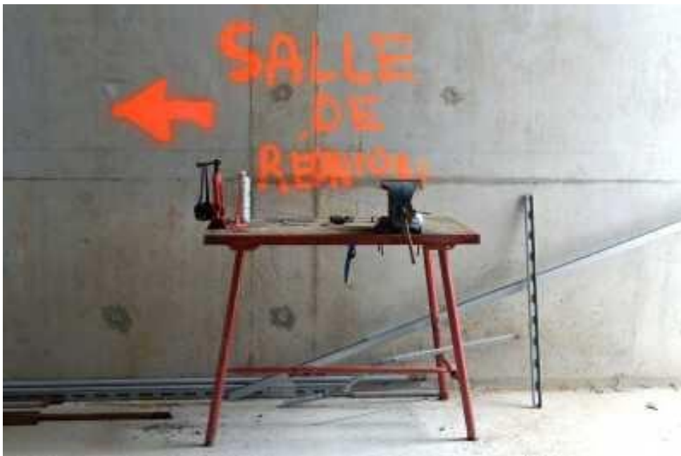
Chantier du Musée de Pont-Aven
